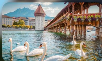
สะพานไมซ์าเปิล
