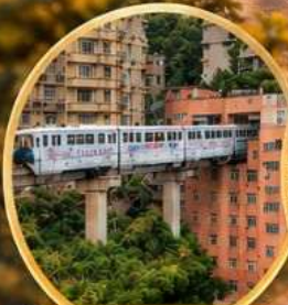
รถไฟฟ้าชุนตง Liziba Station
